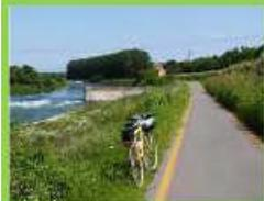
**TAB. 2/1** Realizzazione di fondazione stradale con pavimentazione in **misto stabilizzato di cava**, per interventi in aree in cui esigenze di tutela delle opere idrauliche e/o di tutela paesaggistica ne richiedano l'utilizzazione o come primo intervento in attesa di completamento del manto.
