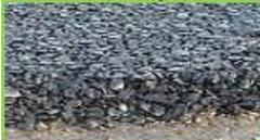
TAB. 2/p pavimentazione in asfalto drenante
