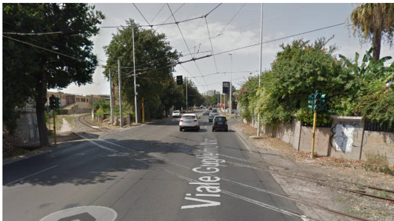
Tratto A -via Galvani-Binari Metro
